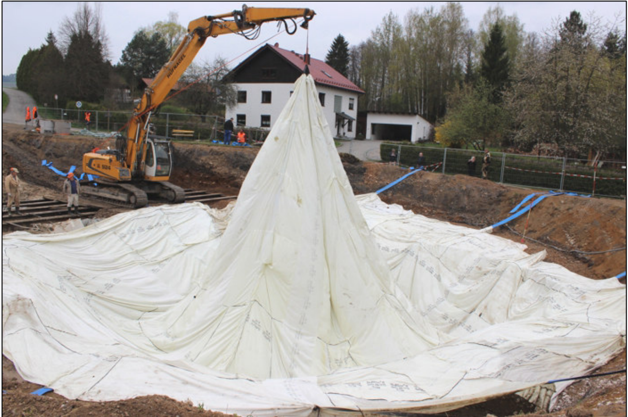
Abbildung 21: Anwendung von Bullflex durch die Firma Beton- und Monierbau GmbH
